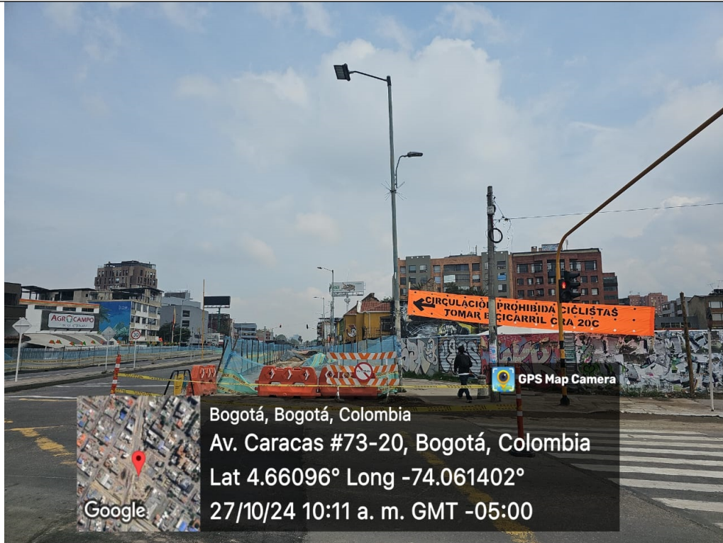
Foto 3. Vista panorámica del predio de la Av. Carrera 20 No. 72 – 14 (dirección catastral) donde se evidencia que la estructura ya no está instalada
